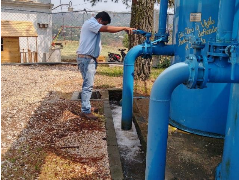
Mantenimiento general de la Planta Potabilizadora de OCUITUCO
