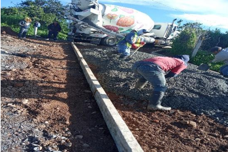
Pavimentación con concreto hidráulico de la Calle Revolución, en la comunidad de Jumiltepec.
