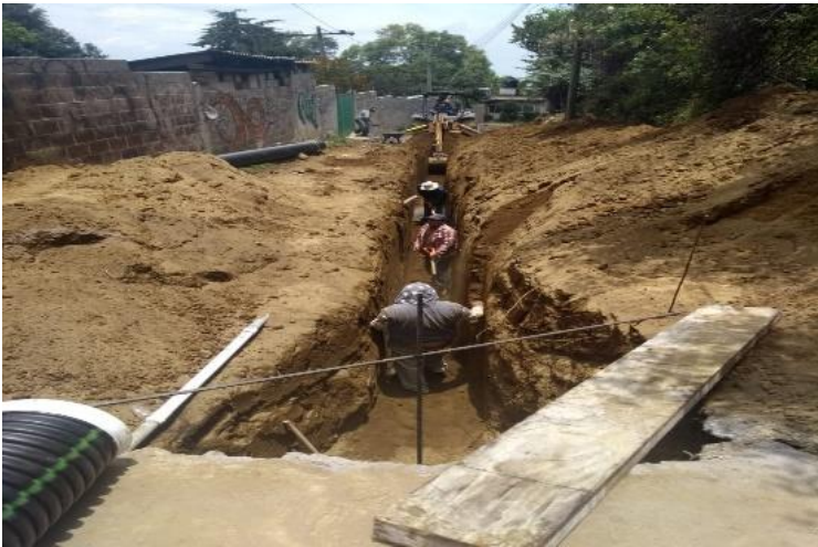
Construcción de Drenaje Sanitario en la calle Emiliano Zapata, en la comunidad de San Miguel Huepalcalco.
