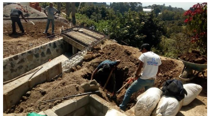
Construcción de Drenaje Pluvial en la Localidad de Huejotengo
