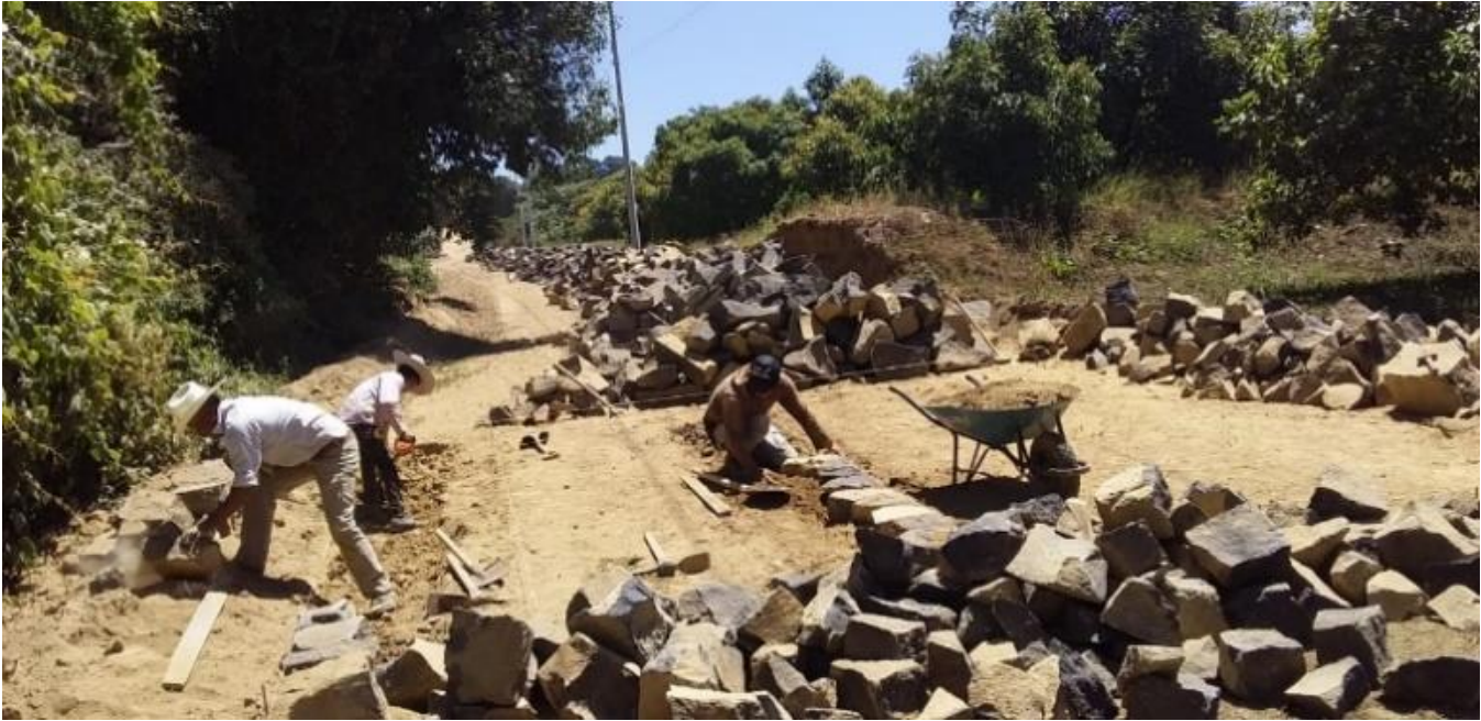
Construcción de Drenaje Sanitario de la calle La Gloria, en la comunidad de Ocoxaltepec
